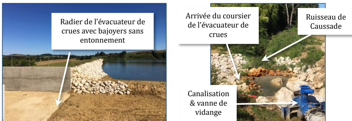
Figure 2 – Quelques images de l'ouvrage réalisé (situation fin mai 2020)
