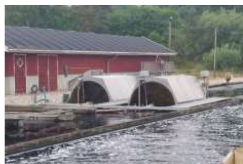
Pisciculture Lofstrup Tambours pour filtration de l'eau
