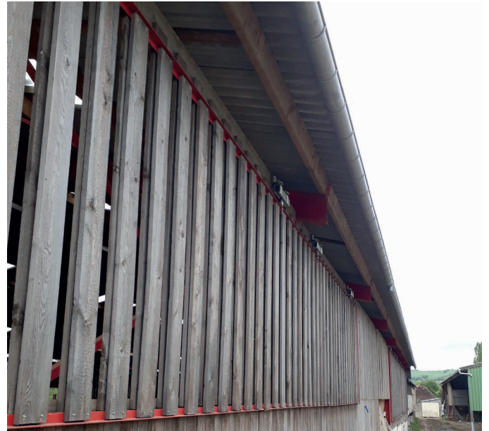
Photo 14 bardage bois modulable (Crédit photo : Idele)
