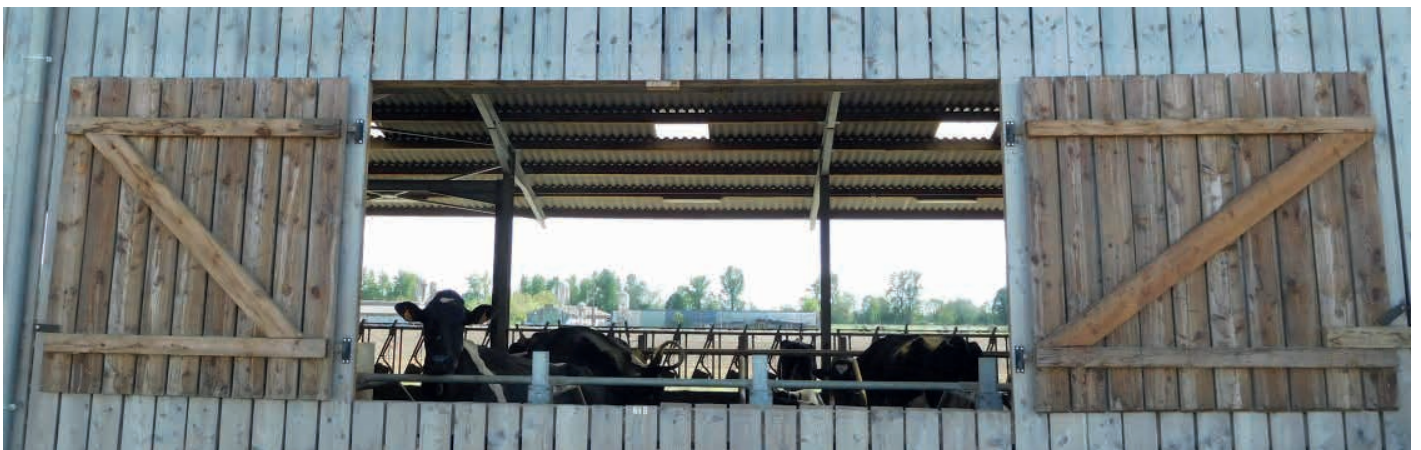
Photo 13 volets bois (Crédit photo : Btpl)
