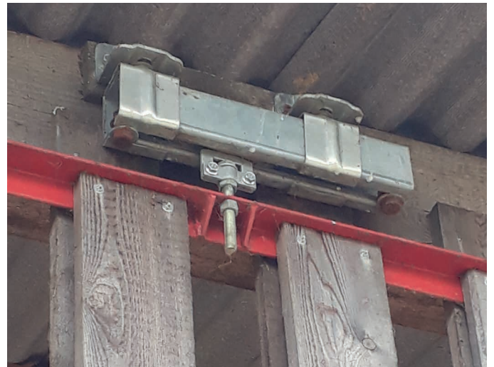
Photo 15 bardage bois modulable (Crédit photo : Idele)
