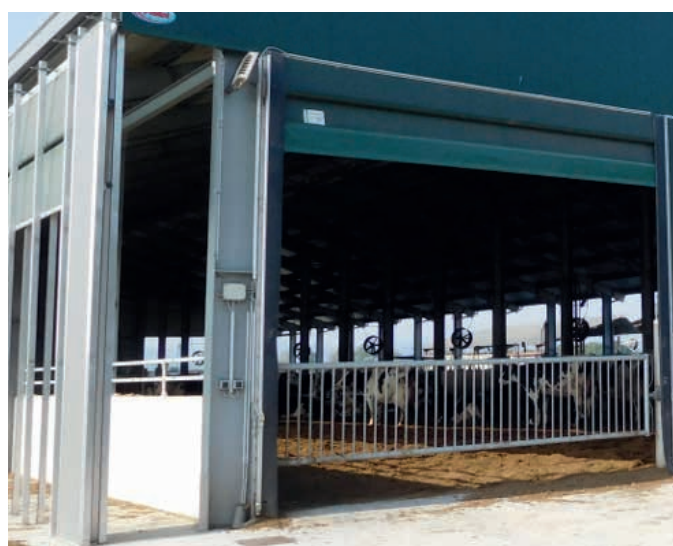
Photo 6. Brise-vent déporté (Crédit : photo BTPL)
