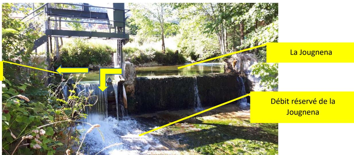
Photo 1 : Barrage infranchissable de la Ferrière-sous-Jougne
