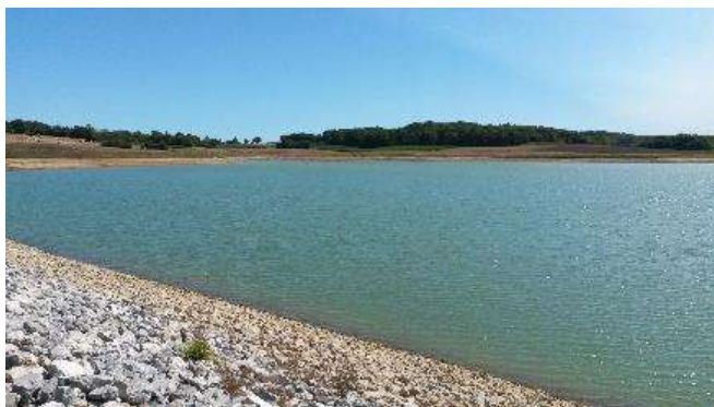
Bassin Adour Amont : Retenue de La Barne (source : IRRIGADOUR)
