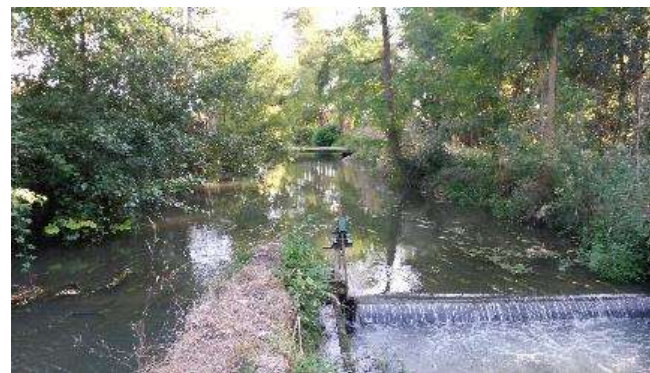
Bassin Adour Amont : Seuil canal l'Alaric (source : IRRIGADOUR)
