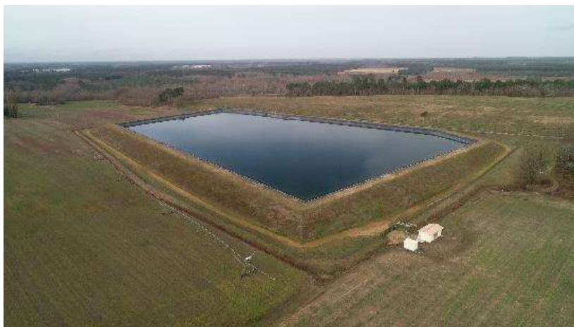
Bassin Midour Aval : Bassine de Beaussiet (source : CA40)
