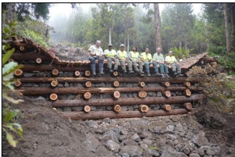
*Photo : seuil RTM « Augustin Payet », premier ouvrage de correction torrentielle réalisé en bois (Cryptoméria) à la Réunion (2016) Photo : ONF*
