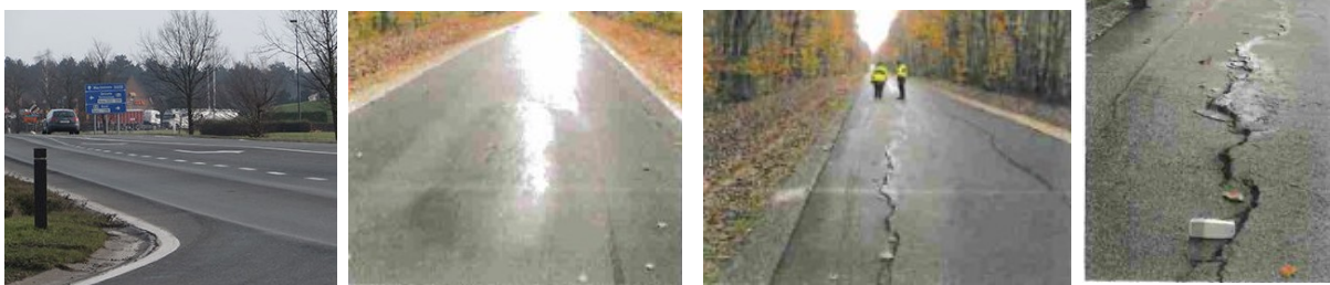
Photos 1 : Orniérage Ressuage de la chaussée Fissuration longitudinale Affaissement en rive (Source : Cerema).
