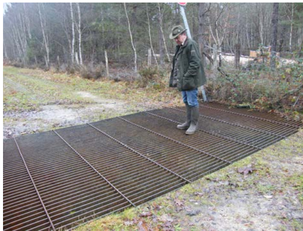
Exemple de barrière canadienne sur chemins ruraux (photographie des auteurs)
