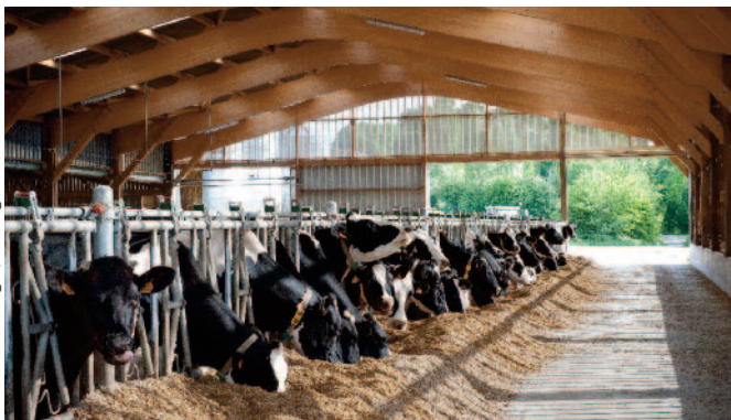
Vaches prim'holstein sous une stabulation en bois lamellé collé
