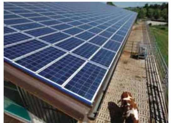
Toute la surface du toit de l'étable est couverte de panneaux photovoltaïques de 110 kWp. L'intégration, les finitions du toit et tous les détails sont exemplaires. Depuis le sud, vue de l'ensemble du bâtiment, avec de la place pour environ 50 unités de gros bétail.
