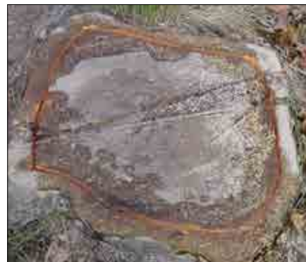
Fig. 19 - Gouttière permettant le dépôt de produit dévitalisant dans la souche (GDON de Marseille)
