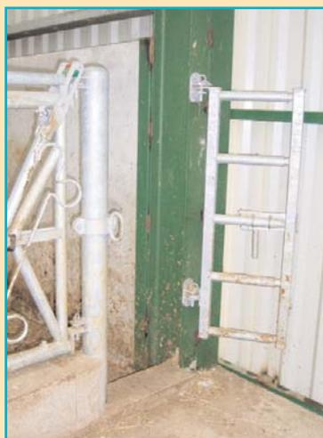
Le portillon inséré sur la ligne d'auge permet l'accès facile depuis le couloir de distribution. Le système d'ouverture doit être simple à manœuvrer.
