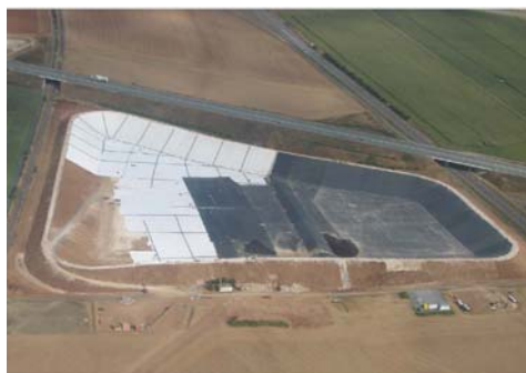
Construction d'une retenue d'eau de substitution
